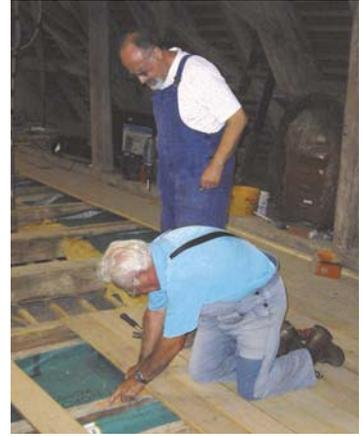
*Arbeiten auf dem Dachboden der Kirche: Eine Wärmedämmung oberhalb des Gewölbes der Kirche hilft Energie zu sparen und wirkt der Kondensatbildung und damit einer Verschmutzung des Gewölbes entgegen.*
